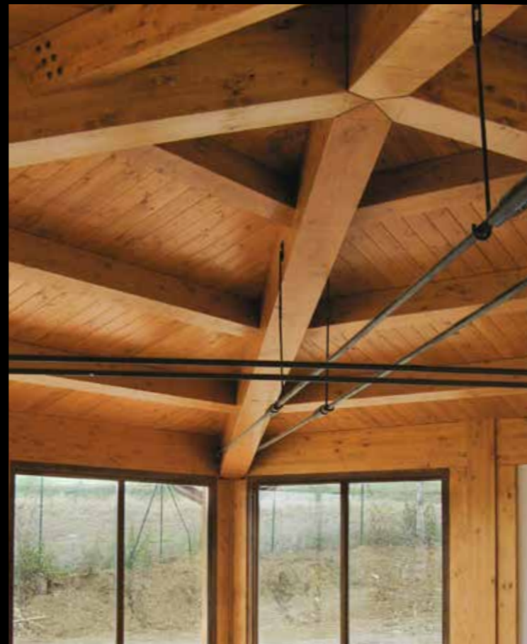
Relais "La Cerreta" padiglioni a Villa Vera - Particolare della copertura in legno lamellare
