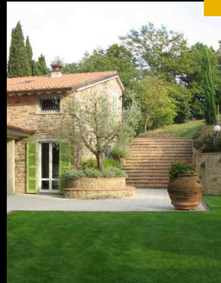
Villa Butali - La dependance con rivestimento in geopietra
