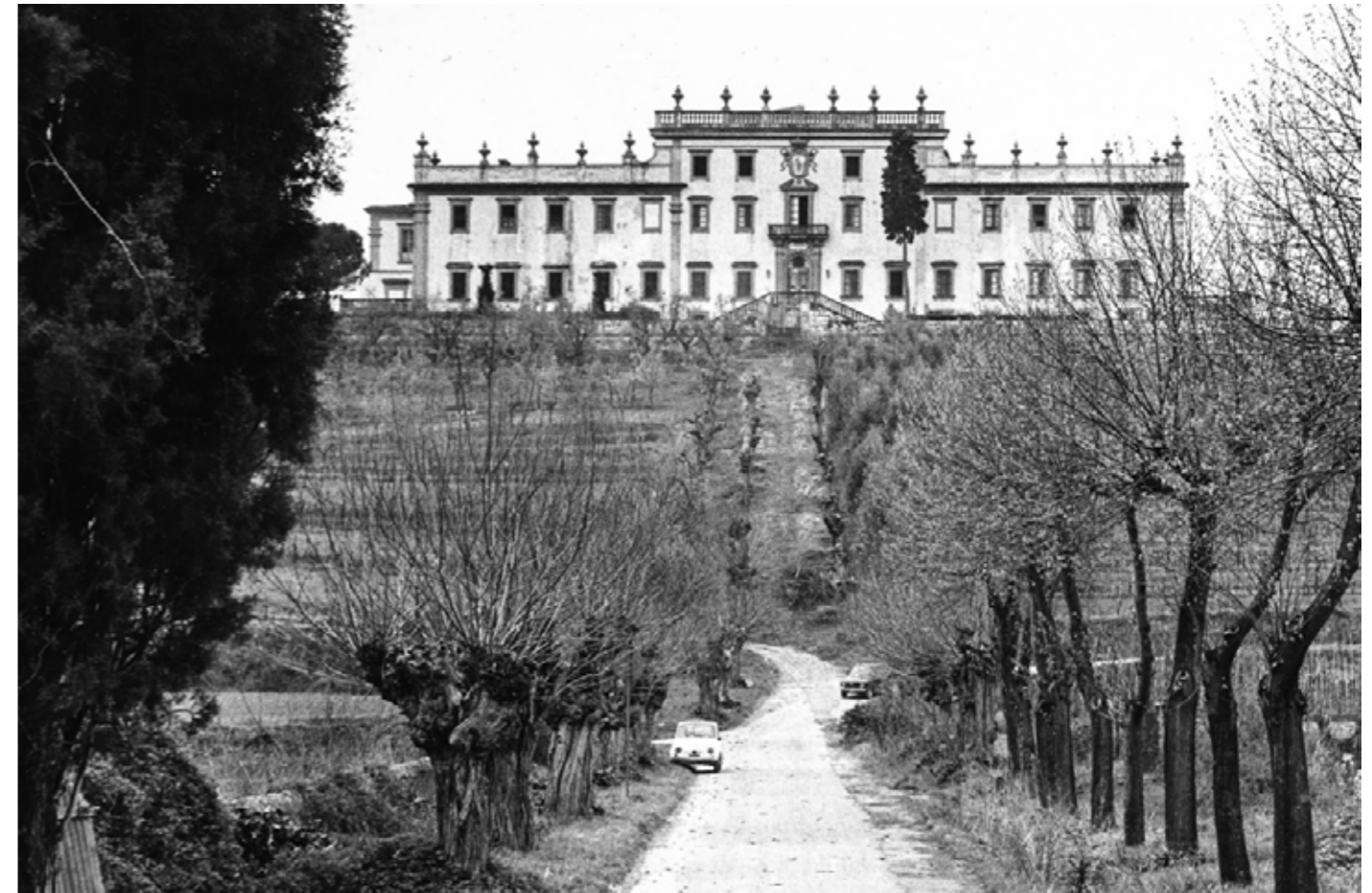
Stato prima del restauro
