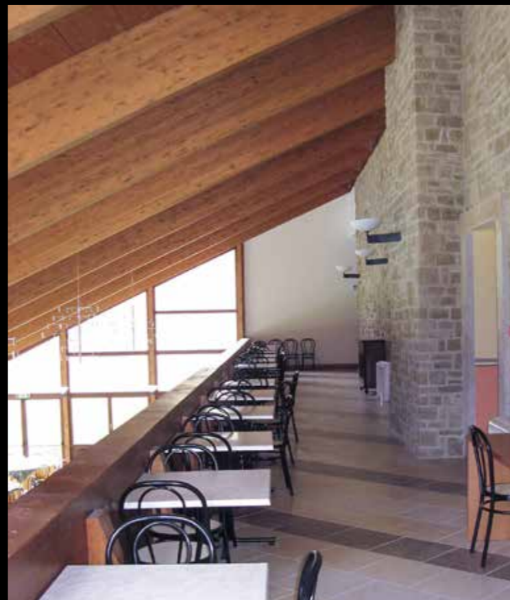
Hotel Appennino - Particolare della del tetto ventilato in legno lamellare
