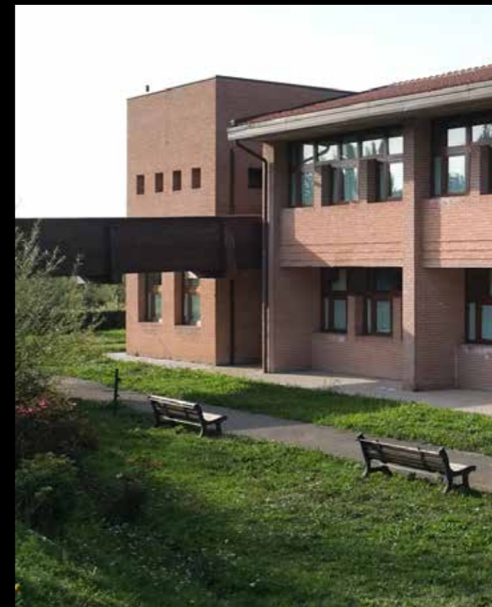
Scuola Media Margaritone - La facciata in laterizio con arretramenti per favorire l'ombreggiamento
